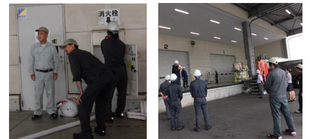
スプリンクラー操作手順を確認&指導中(防災電設様にはいつもお世話になってます 感謝！)
